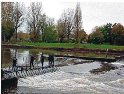
© NEC – Abaissement Bléré
