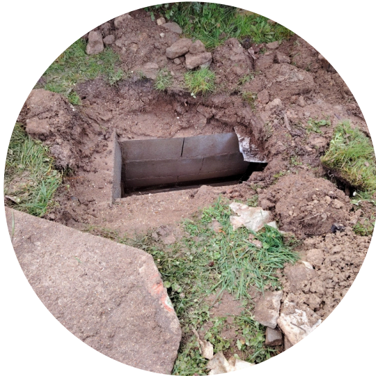
Remise en état des trappes de visite du réseau d'eaux pluviales Impasse du Moulin
