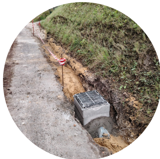
Pose d'un réseau d'eaux pluviales Rue de la Pilouette
