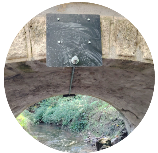
Rejointement et chainage Pont du camping
