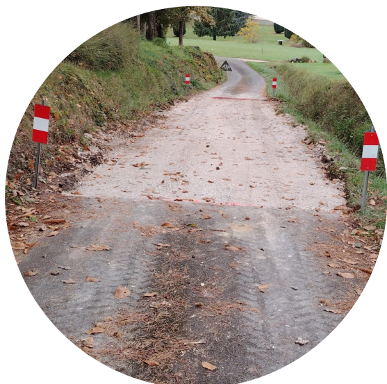
Enlèvement racines et mise en enrobé Chemin des Hauts Bernoux
