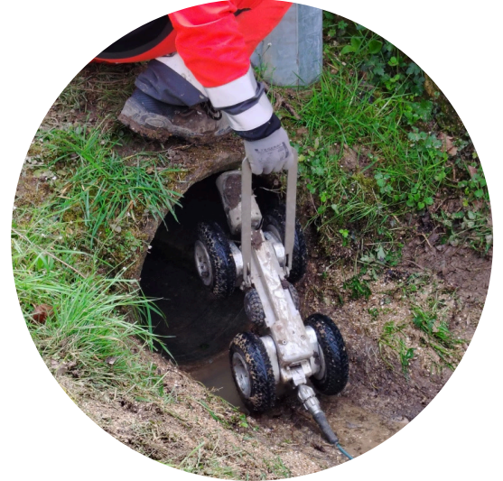
Hydro curage du réseau d'eaux pluviales avec inspection par caméra Impasse du Moulin
