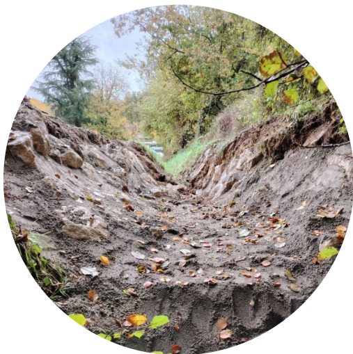
Enrochement fossé Rue de la Penauderie
